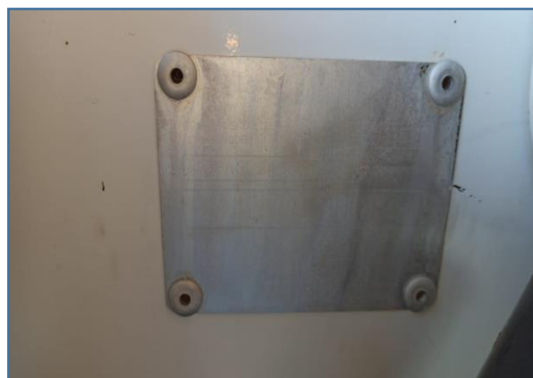
PLACA COM DADOS DO EQUIPAMENTO ESTÁ BEM DESBOTADA, DADOS DIFÍCEIS DE SEREM LIDOS
